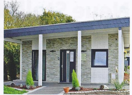
■ Der Womopark Xanten kann ein schickes Sanitärgebäude und jetzt neu auch eine WellnessOase anbieten.
